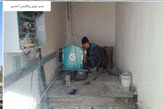
نصب موتور بریکر در آسانسور
