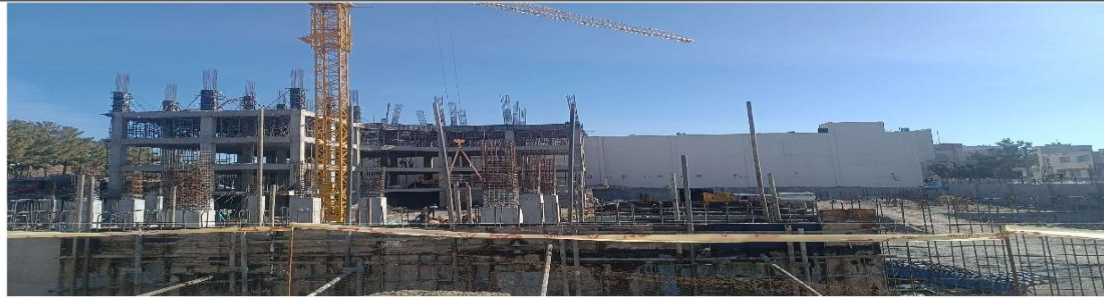
بتن ریزی ستون های طبقه ۳-۲ بلوک ۲
